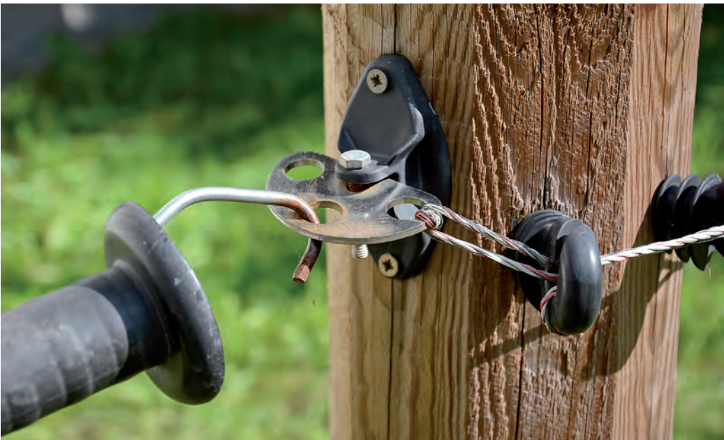
Unsichere elektrische Verbindung
